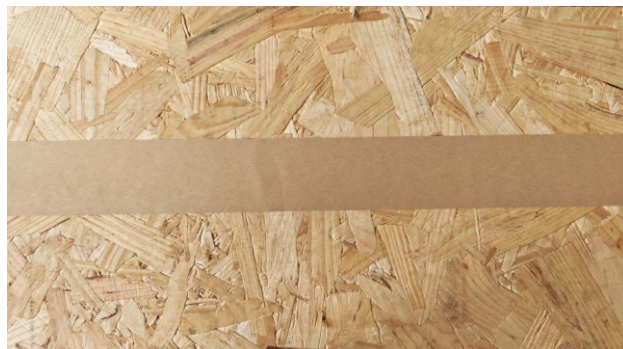
Используйте клейкую ленту VAPOR TAPE для герметизации плоских стыков между плитами OSB.
