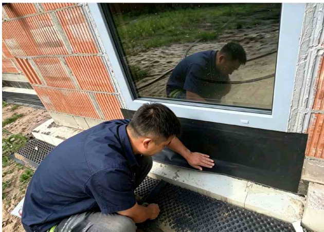
Используйте EPDM TAPE для герметизации нижних стыков панорамных окон с выходом на террасу.
