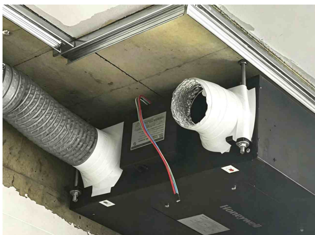
Герметизация узлов прохода круглых труб и инженерных коммуникаций.
